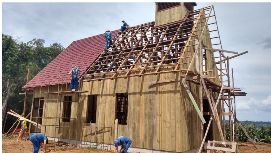
Imagem 9: Detalhes da colocação do telhado e do fechamento com tábuas
