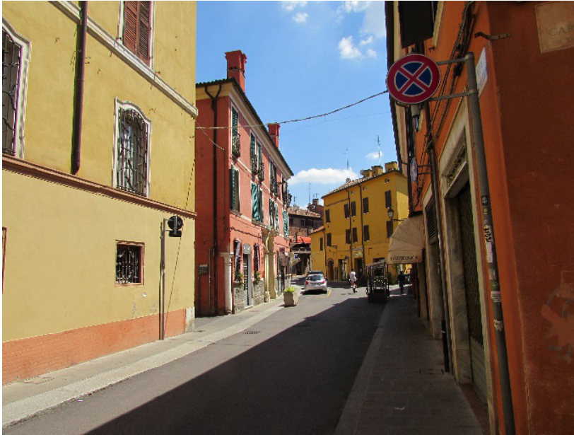
Figura 9 - Adequação do tratamento das fachadas de acordo com a tipologia na via Saraceno .
