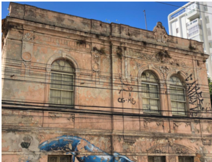
Figura 9 - Fachada lateral da casa maior
