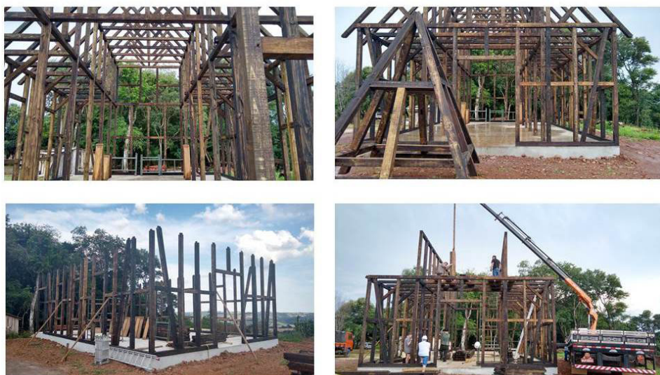
Imagem 8: Detalhes da montagem da estrutura
