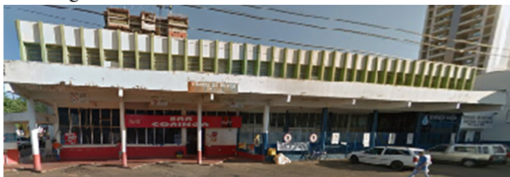
Figura 15 - Rodoviária do interior, vista da Rua Clevelândia.
