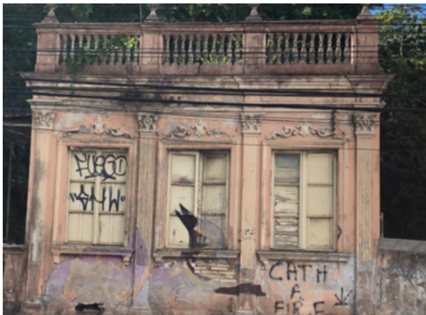
Figura 11 - Fachada frontal da casa menor
