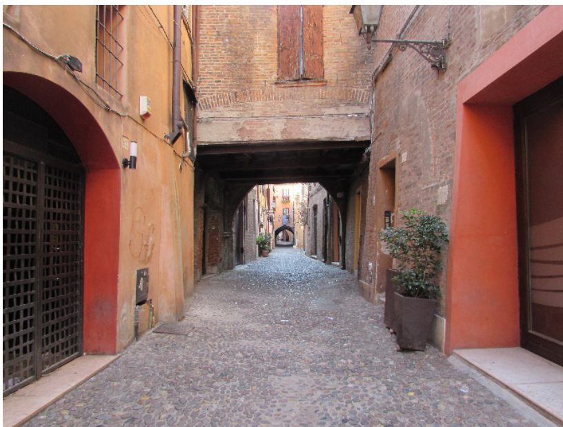
Figura 12 - Preservação da paisagem cultural enquanto ente íntegro a partir do tratamento individualizado de cada construção na via delle Volte .
