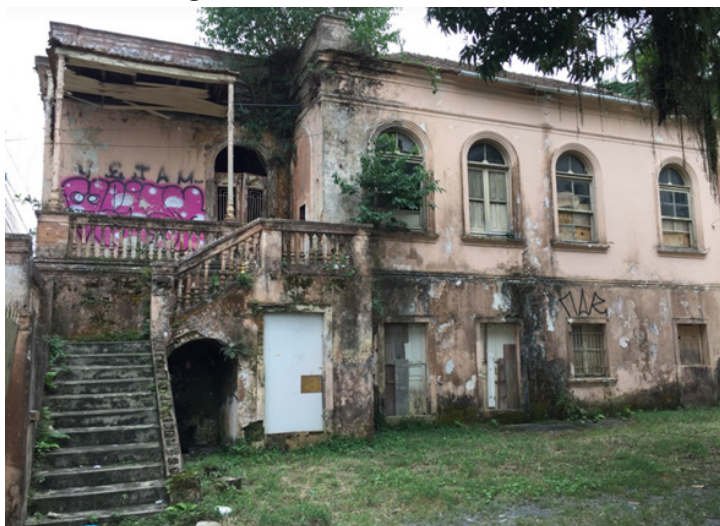
Figura 10 - Fachada lateral da casa maior
