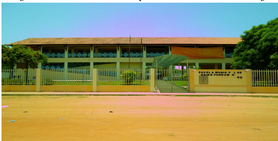
Figura 1: Vista frontal da Escola Municipal de Ensino Fundamental de São Diogo
