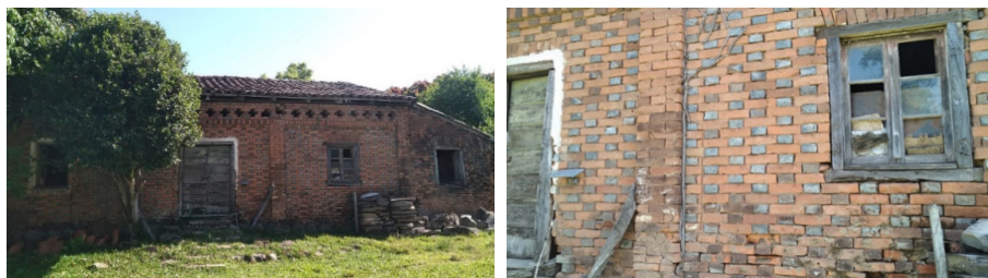
Figura 4 – Casa de Túlio Brondani, com destaque para a parede de tijolos queimados com cinzas em Vale Vêneto, São João do Polêsine/RS
