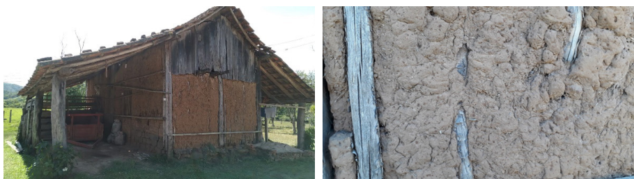
Figura 2 - Casa da Nona Izalda Catarina Bevilacqua Dotto. Destaque para a parede feita de barro, madeira e palha de trigo na casa de Dona Izalda, em Vale Vêneto, São João do Polêsine/RS.
