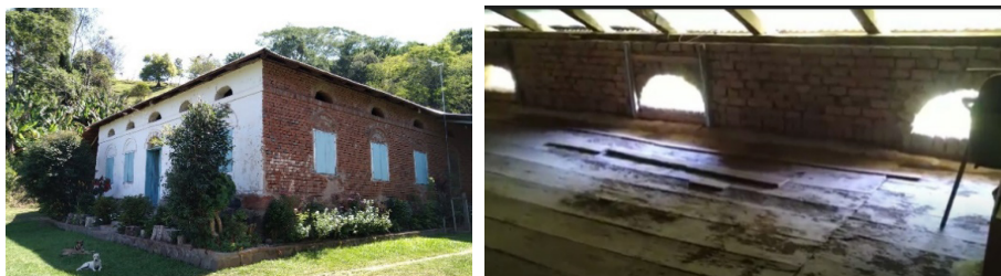
Figura 3 – Casa da família Brondani, destaque do assoalho do sótão e dos respiros da residência em Vale Vêneto, São João do Polêsine/RS
