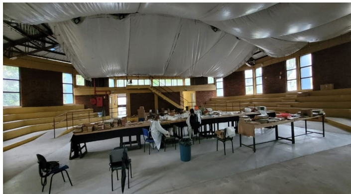
Imagem 1 - Interior do Centro Pogetti, com lona de proteção
