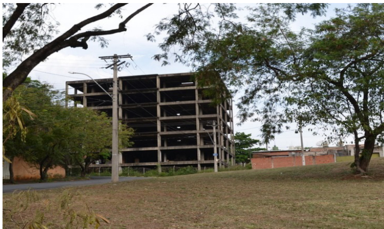
Figura 6: Estrutura abandonada em Piracicaba
