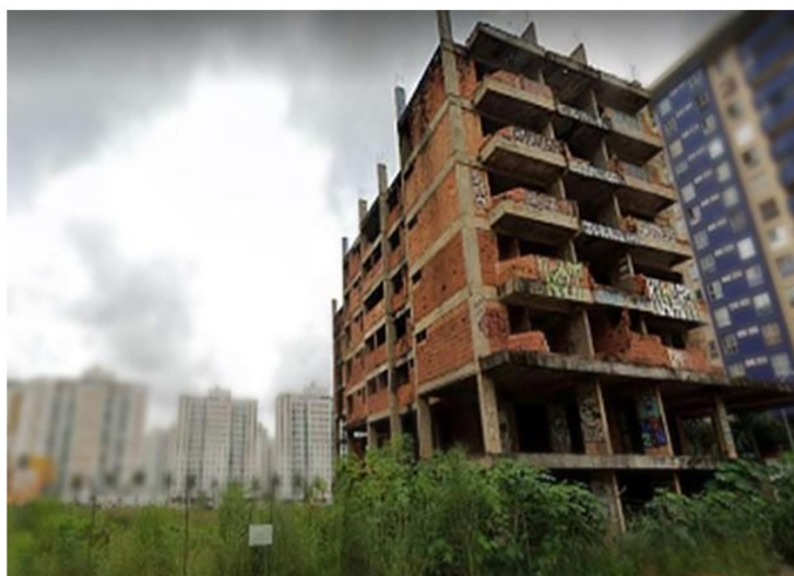
Figura 5: Prédio abandonado no Distrito Federal
