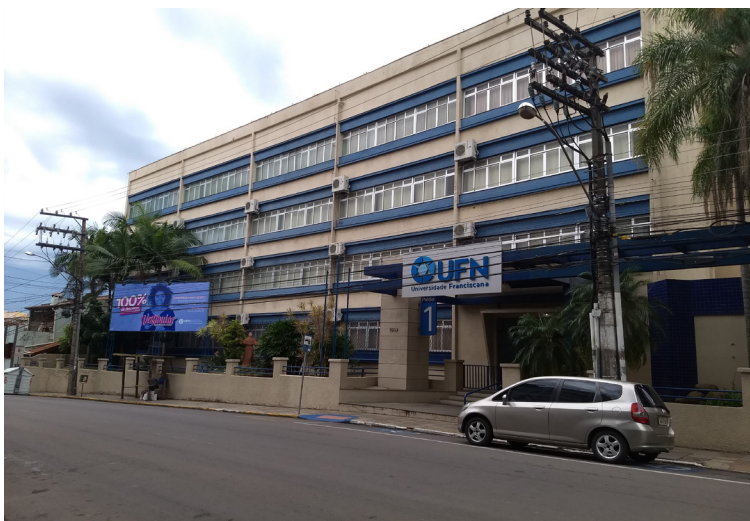
Figura 89 – Conjunto I, prédio 1 da UFN
