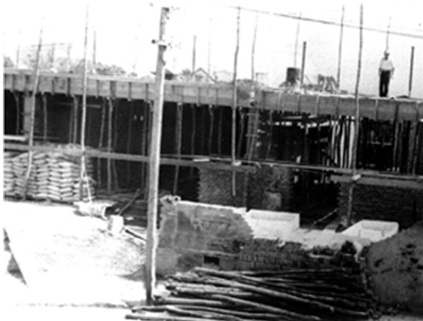
Figura 5 – Obras da construção do prédio da FIC
