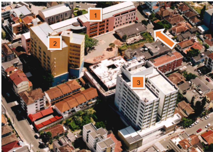
Figura 99 – Vista aérea das instalações físicas do Conjunto III da UNIFRA
