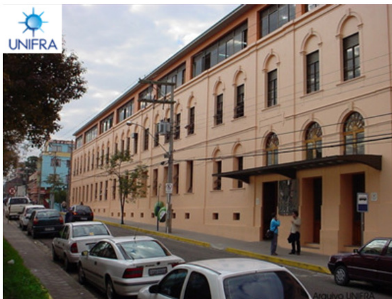
Figura 97 – Prédio do antigo Educandário São Vicente de Paulo após reforma
