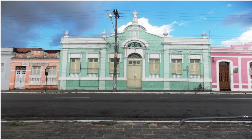
Figura 2: Fachada do Casarão 34.
