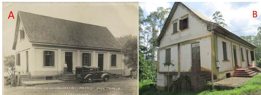
Imagem 08: Comercial Schoeler, Linha Sede Capela, interior de Itapiranga. Perspectiva antiga (A) e atual (B). Fonte: Arquivo do autor.
