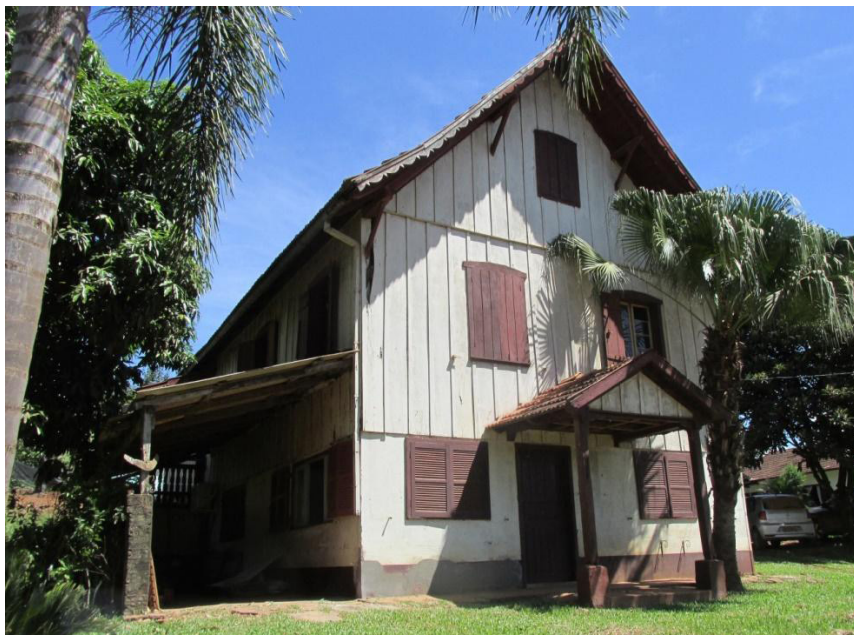
Imagem 1 - Residência Hauser, de Linha Presidente Becker, Itapiranga, construída em 1940
