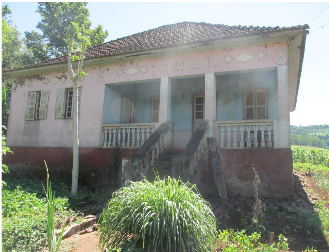
Imagem 4 - Residência Dünkersleben, localizada na Linha Chapéu, Itapiranga. Construída em 1959.
