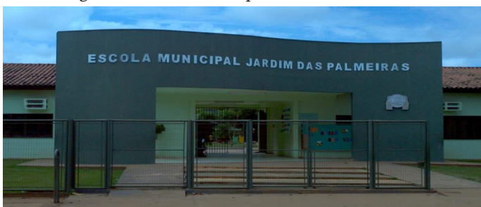
Figura 02: Escola Municipal Jardim das Palmeiras
