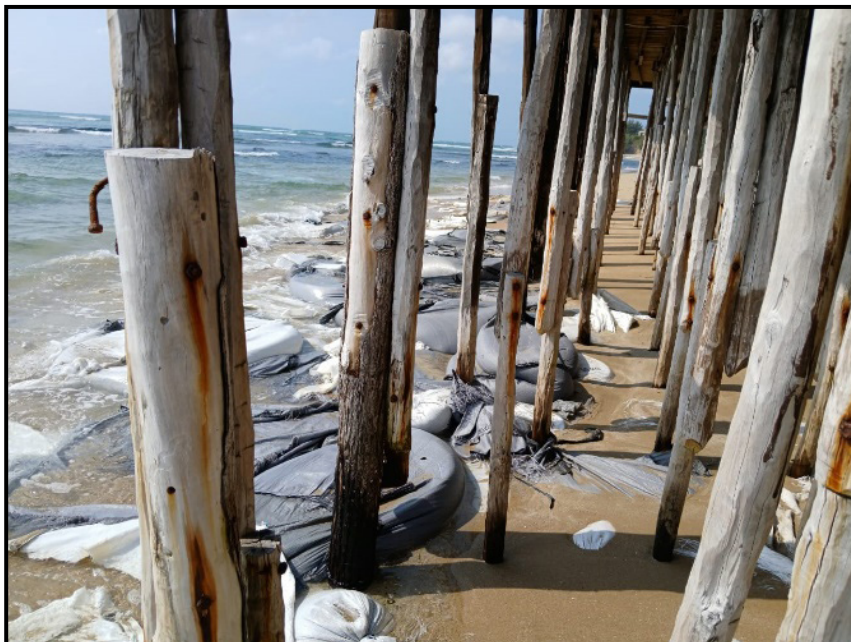
Figura 14: Barreiras de sacos de areia na costa da praia de Barra, para impedir a evasão das águas do mar
