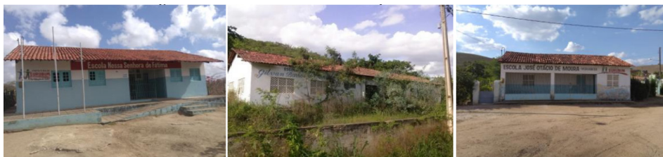
Figura 10: Prédios de escolas do campo extintas em Surubim
