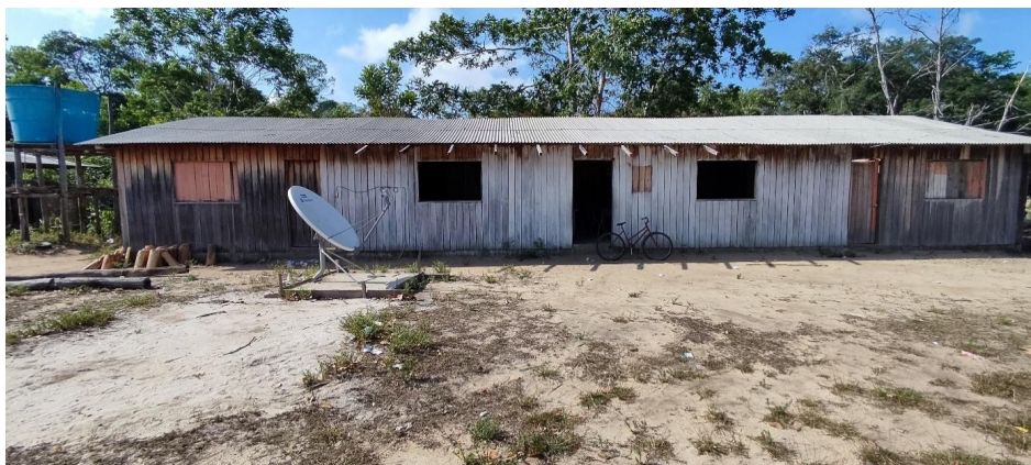
IMAGEM 1: ATUAL ESTRUTURA UTILIZADA PARA AS AULAS DA EMEF DE PRATA.
