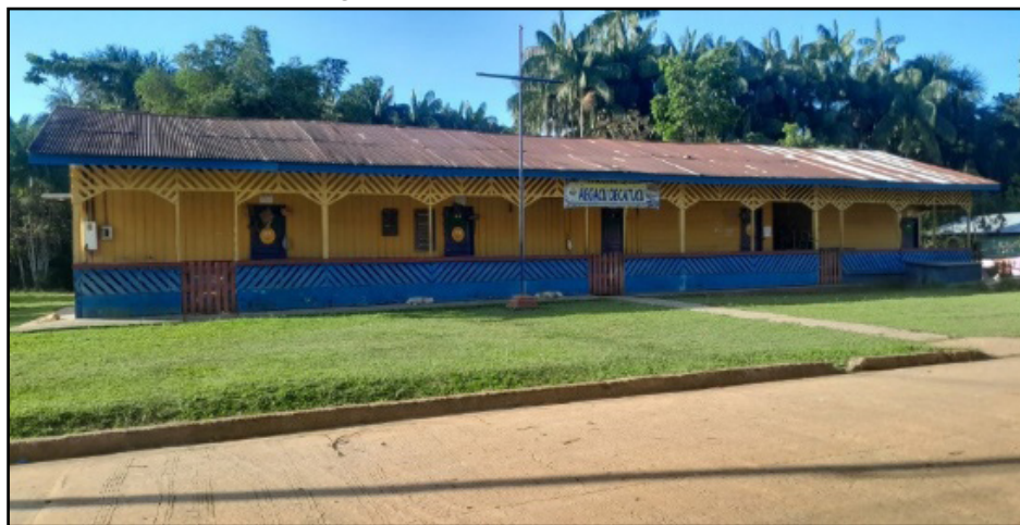
Figura 1 - Estrutura física da escola
